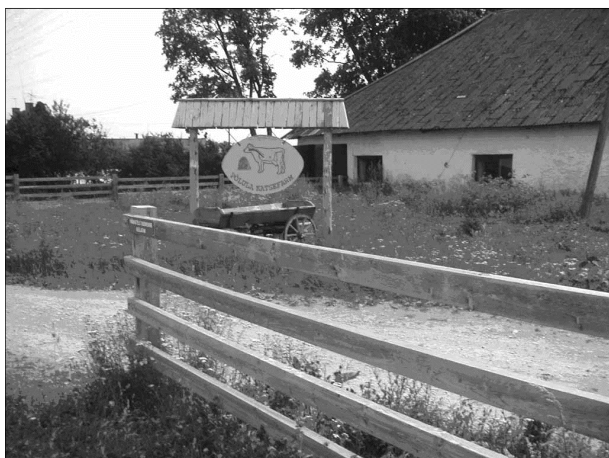
Joonis 13. Katselaudaks rekonstrueeriti omaaegse Oru talu karjalaut (foto M. Ots)
