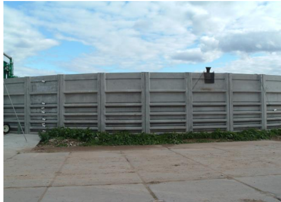
Joonis 2. Madala seinaga (kuni 4 m) rõngasmahuti (foto A. Nõmmeots) Figure 2. Ring shaped manure storage with low wall (to 4 m)(photo A. Nõmmeots)
