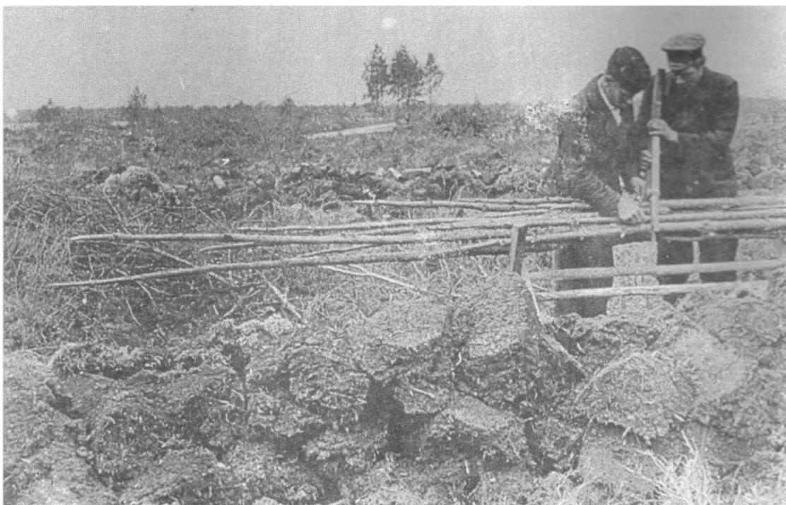
Lattide sidumine dreniks madal soo kuivendamisel Tooma Sookatsejaamas 1911. a.
