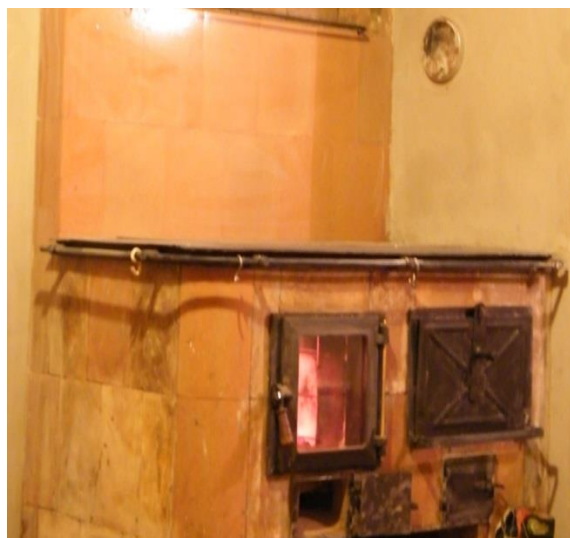
Joonis 1. Eesti oludes uude pilukoldega rekonstrueeritud pliit (foto K. Hovi).
