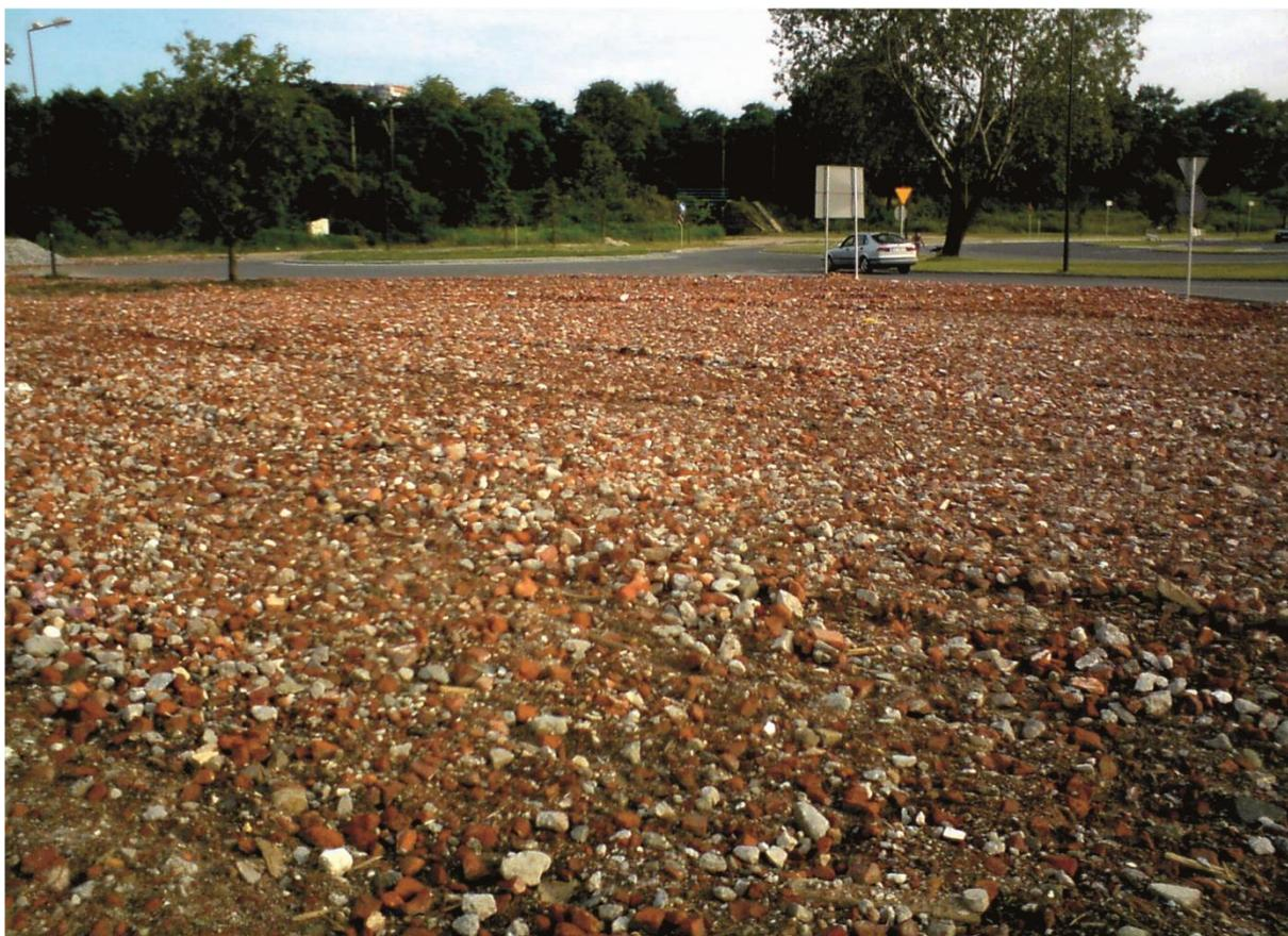
**Joonis 12.** Ehituse kiviprügiga (purustatud telliskivid ja betoon) kaetud mullapind. Foto: A. Greinert.
