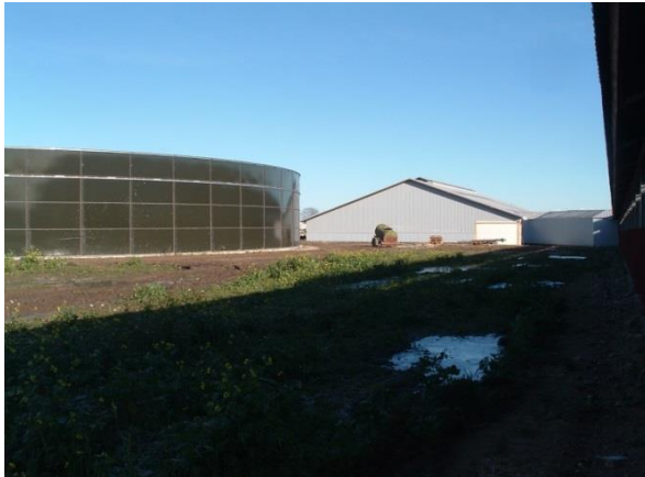
Joonis 3. Kõrge seinaga (üle 4 m) rõngasmahuti (foto A. Nõmmeots) Figure 3. Ring shaped manure storage with roofing (photo A. Nõmmeots)
