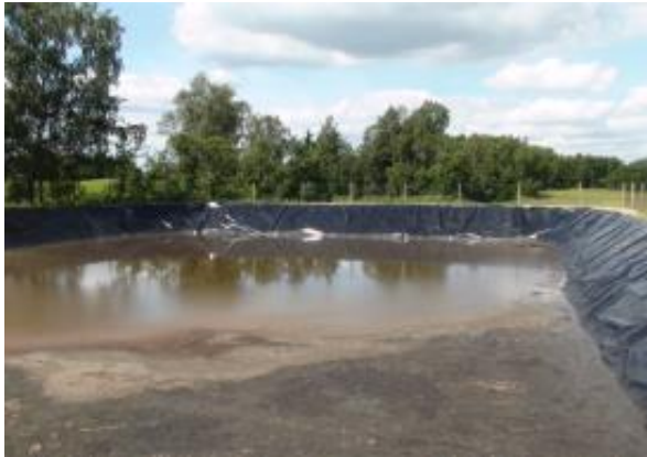
Joonis 1. HDPE kilest laguuntüüpi hoidla (foto A. Nõmmeots) Figure 1. Lagoon type manure storage (photo A. Nõmmeots)
